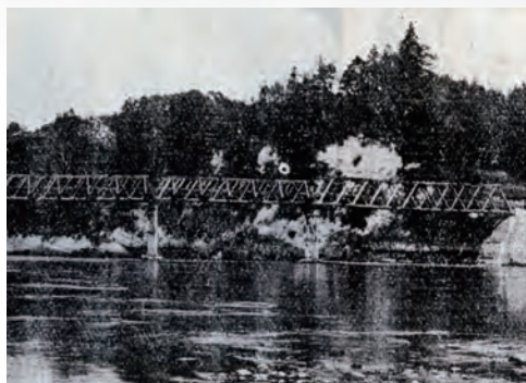
藤橋 (1895、写真は再架橋か)
