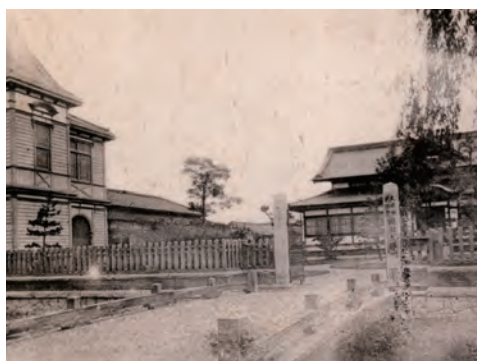
大日本武徳会岡山支部武徳殿・事務所 (1911)
