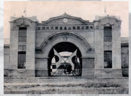
中国六県連合畜産馬匹共進会仮建築 (1915)
