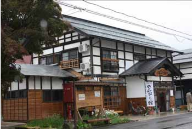
県補助で改修した生活体験館のんびり館
